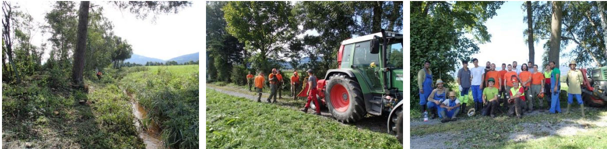
Das Hochwasserprofil am Mittleren Seegraben wird freigelegt: partnerschaftliche Zusammenarbeit mit dem BAZ (Bundesasylzentrum) Altstätten und der regionalen Zivilschutzorganisation, Fotos: Patrick Knür
