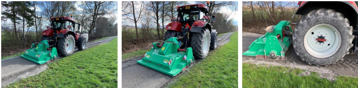
Kiesstrassen fräsen, April 2019, Fotos: Patrick Knür
