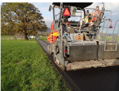
Strassensanierungen Siedlungsgebiet Kriessern (mit Asphaltbewehrung) und Höhlistrasse Altstätten, Fotos: Patrick Knür
