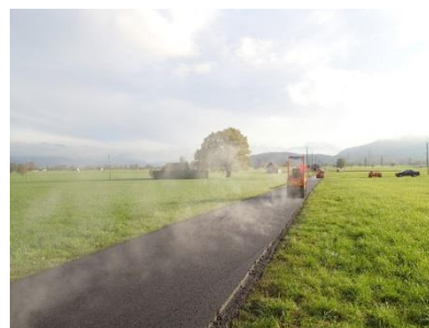
Strassensanierungen Siedlungsgebiet Kriessern (mit Asphaltbewehrung) und Höhlistrasse Altstätten, Fotos: Patrick Knür
