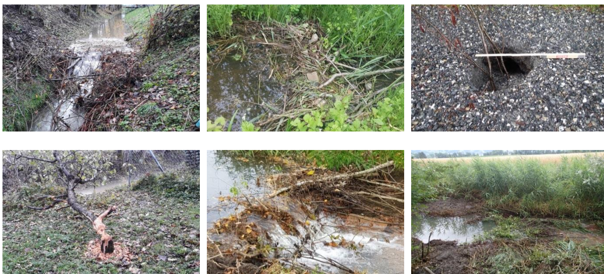
Biberbauten und -schäden; Fotos: Patrick Knür
