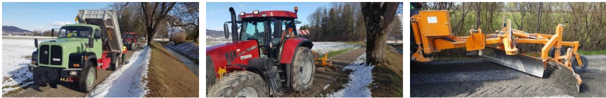
Strassenunterhalt: Einkiesen, April 2019, Fotos: Patrick Knür
