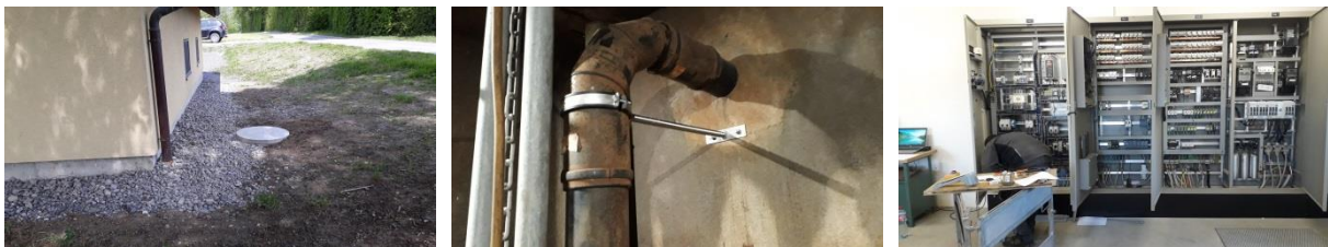
Unterhaltsarbeiten an den Pumpwerken, Fotos: Markus Keel
