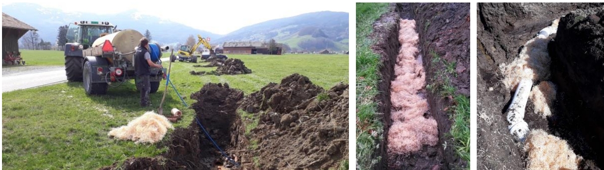
Unterhaltsarbeiten an den Drainagen, Fotos: Markus Keel
