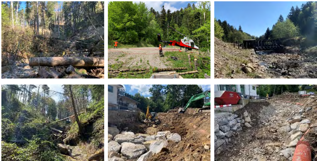
Bachbegehungen und Unterhaltsarbeiten an den Bergbächen; Fotos: Patrick Knür
