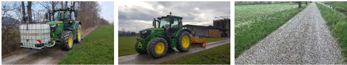
Unterhalt der Kiesstrassen, April 2020, Fotos: Patrick Knür
