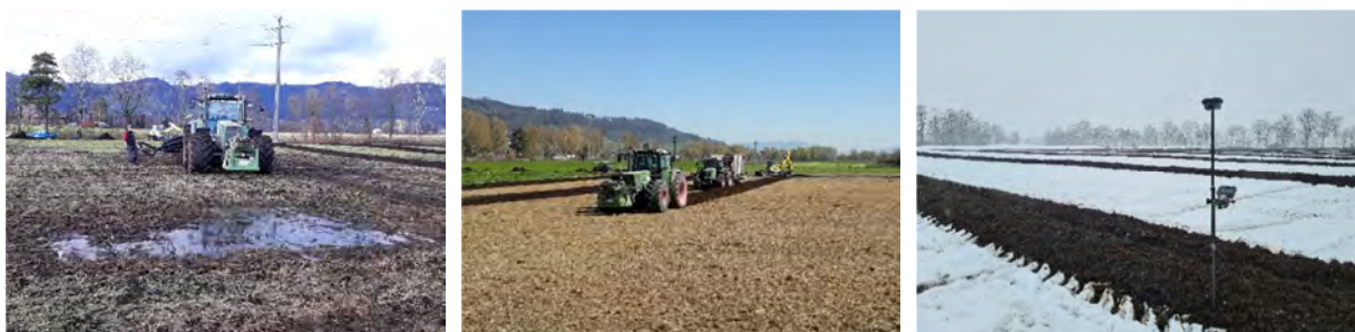
Unterhaltsarbeiten an den Drainagen, Fotos: Markus Keel
