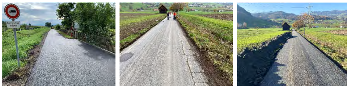
Strassensanierungen Stöckenweg Oberriet sowie Bühlfeldstrasse (vorher/nachher) Altstätten, Fotos: Patrick Knür
