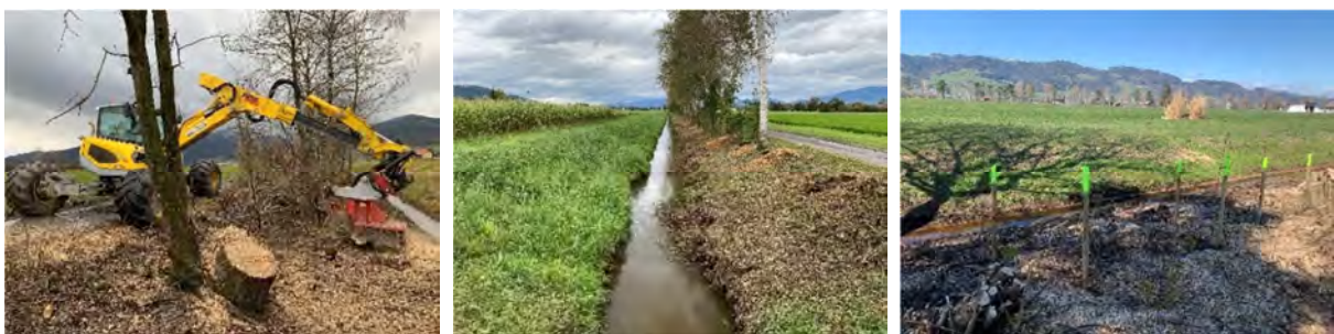
Stockfräsen, Hochwasserprofil freiholzen und Jungpflanzen setzen; Fotos: Patrick Knür
