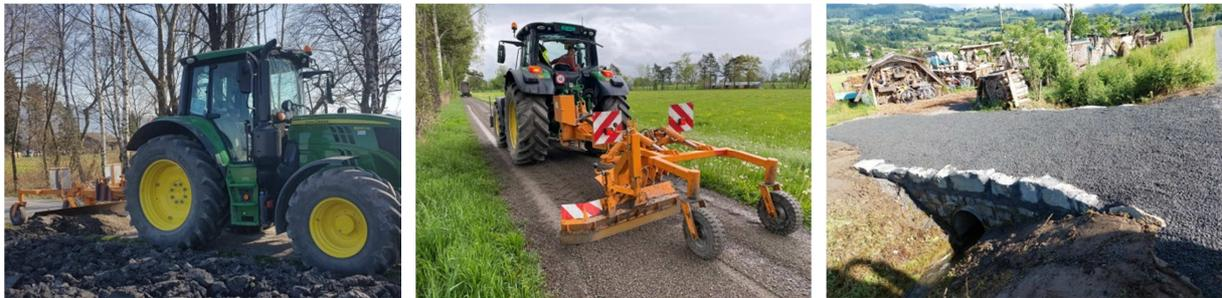
Strassen abziehen und Kies verteilen mit dem Planierschild. Rechts: Sanierung eines Durchlasses am Luxgraben.
